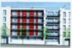
2 Immeuble d'angle nouvelle rue Jules Dorget et rue de Nabécor (maître d'ouvrage Promatiance, architectes Malet et associés). Réalisation de 50 appartements en accession à la propriété.
