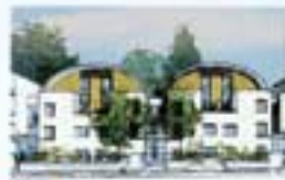
4 Immeubles rue Pierre Villard architectes André-Michel-Boorbul. Réalisation de 37 appartements locatifs, du T1 au T5. Démarrage des travaux novembre 2006, livraison mai 2007.
